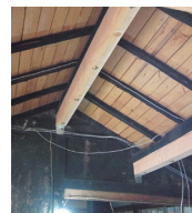
丸太梁撤去後
