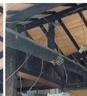
丸太梁撤去前
