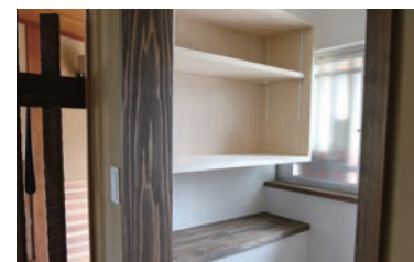
使い勝手を考慮し、高さ調整を行ったトイレ収納
