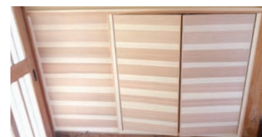
繋がりを持たせた腰壁と下駄箱
